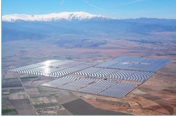
شكل 14 محطة الطاقة الشمسية Andasol بقدر 150 ميجاوات في إسبانيا هي محطة طاقة شمسية حرارية مكافئة تخزن الطاقة في خزانات من الملح المصهور حتى تتمكن من الاستمرار في توليد الكهرباء عندما لا تكون الشمس مشرقة.
